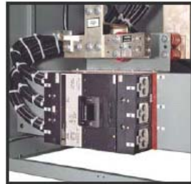
FIG.16 – Conexões de terra e neutro
